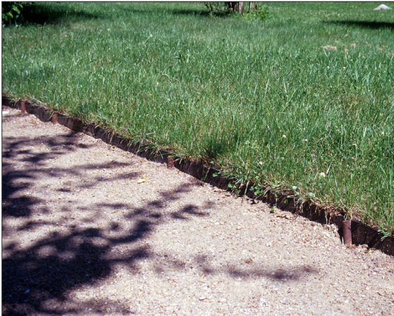
Kantensicherung durch Wurzelschutzbahnen im Bürgergarten.
