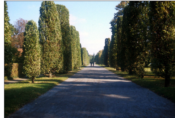
Die Eichenallee in ihrem derzeitigen Zustand. Die alte Tragschicht liegt aufgrund von Geländeerhöhungen unter einer starken Schicht aus Schlacke. Neuer Garten Potsdam, Photo: TU Berlin, September 2001.
