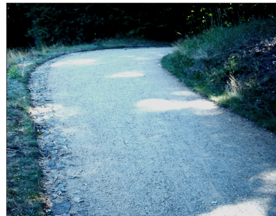
Der Weg am Tumulussee weist seitliche Wasserrinnen aus Feldsteinpflaster auf. Branitzer Parkanlage von PÜCKLER-MUSKAU. Photo: TU Berlin, Juli 2001.
